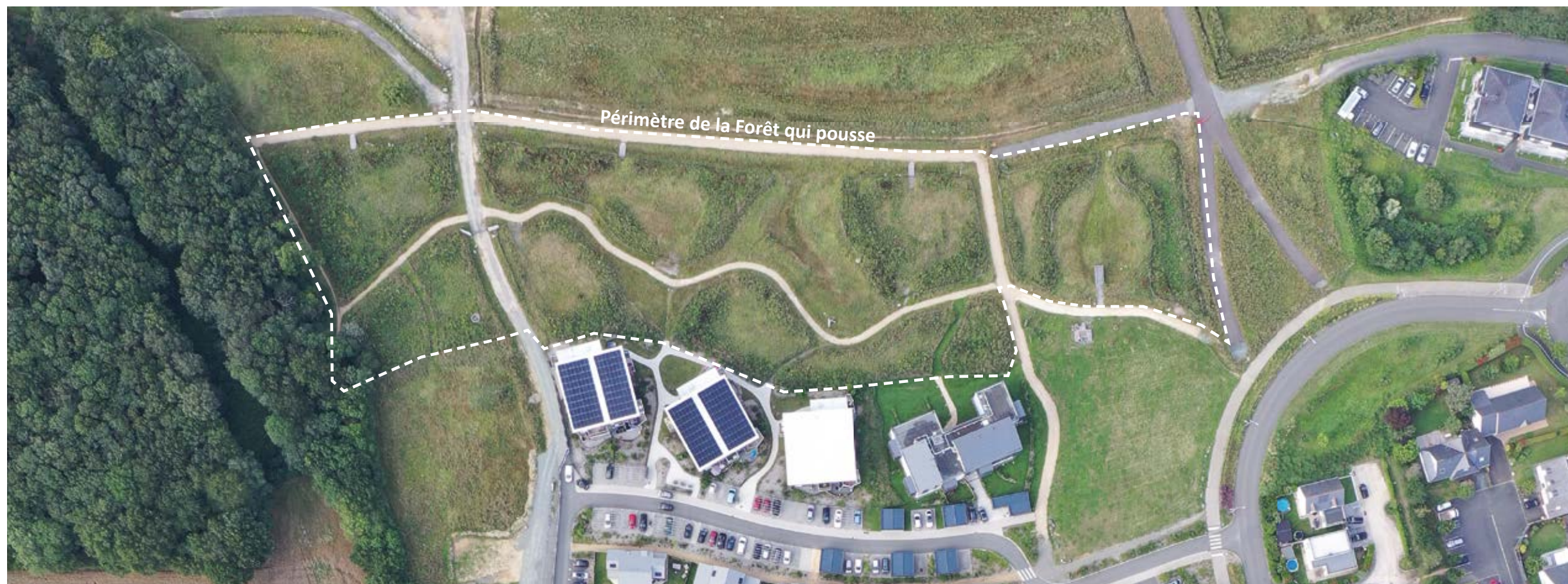
Vue aérienne de la Forêt qui pousse - 2021
