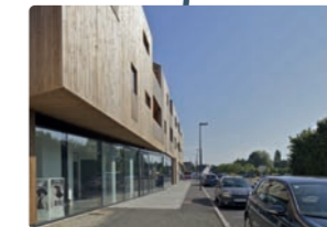
Rez de chaussée commerçants
