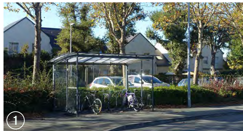
Stationnement couvert de qualité, av. de la Grange aux Belles.
