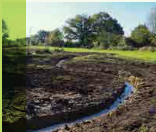
Travaux sur la zone humide d'Ecuillé (ALM, SMBVAR)
