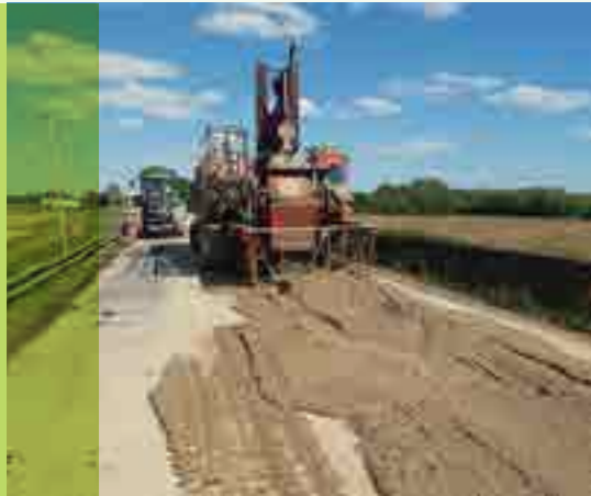
Travaux sur la digue domaniale du Val d'Authion
