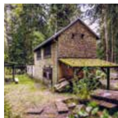
Musée-carrière à ciel ouvert ancienne carrière de granit
