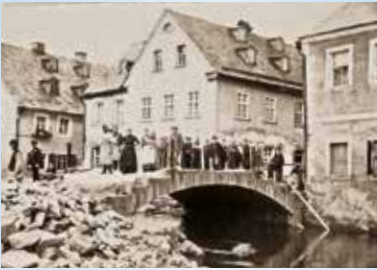
La construction du pont « Selbachbrücke » le long de la rue « Hohenberger Straße », vers 1921
